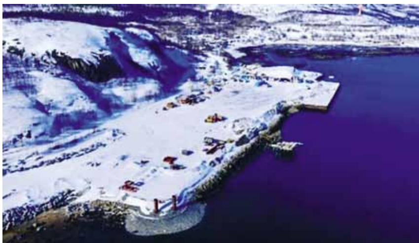
Строительство морского угольного терминала «Лавна» [20]
